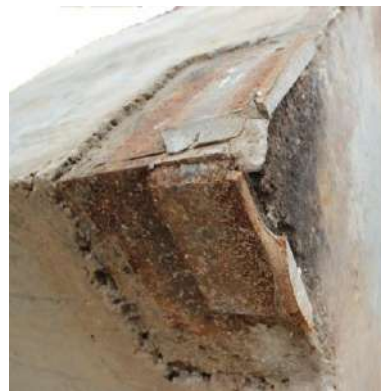
Рис.2. Разрушение уголков
